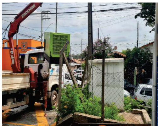
2 -INSTALAÇÃO GERADOR ALUGADO
