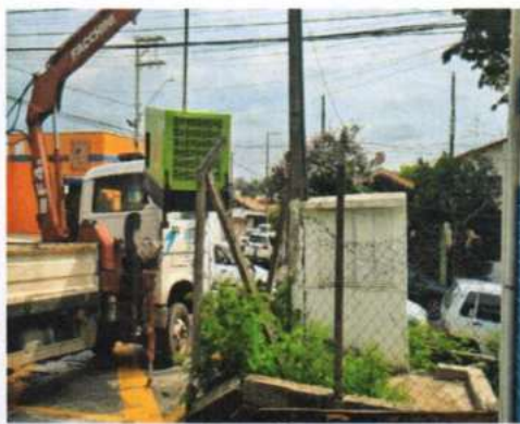
2-INSTALAÇÃO GERADOR ALUGADO
