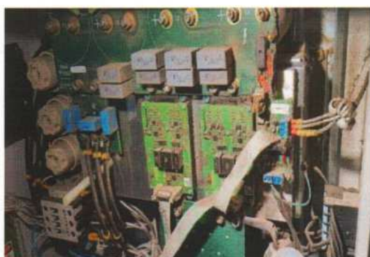
4-REPARO EM PLACA RAIO-X
